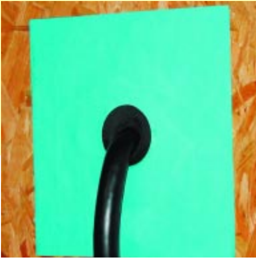
◀ Vorgefertigte Manschette für die Leitungsdurchführung.
